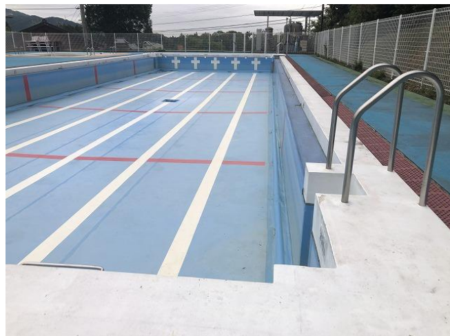
<きれいになったプール>
