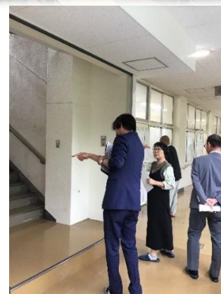
配膳室設置に伴い3棟2Fには防火扉も設置されました
