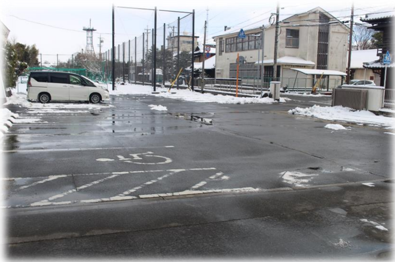
融雪剤散布後の整備された校門・駐車場です。
